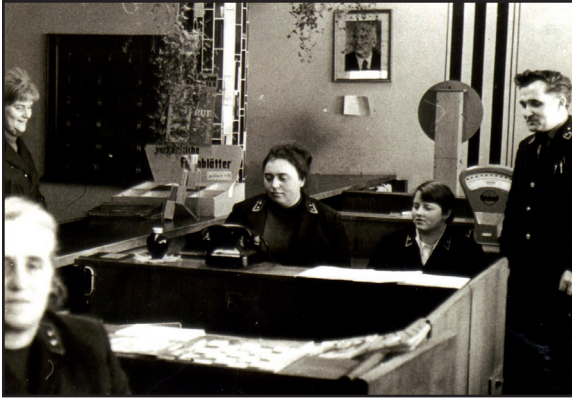
Schalteranlage im Postamt Prora 1 (1964)
