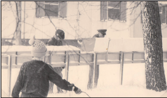
Briefzustellfachanlage Diese Anlagen wurden vor größeren Wohneinheiten, Siedlungen, Stichstraßen usw. aufgestellt, mit dem Ziel der frühzeitigen Verfügbarkeit der Tageszeitungen. Die Bürger mussten hier ihre Post selber abholen. Die Anlagen bestanden aus einzelnen Kästen mit sechs Einheiten.
